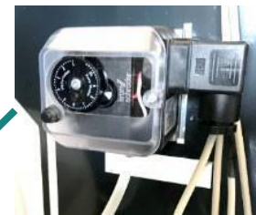
Ограничитель давления дымовых газов 9 мбар
