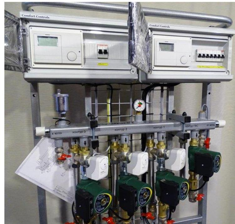
Модуль ГидроЛОГО DN20
