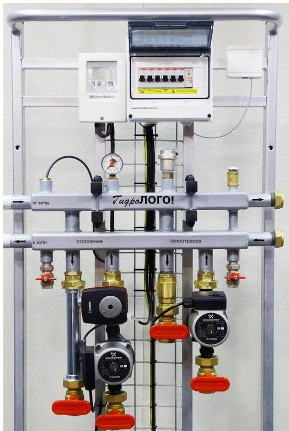
КОМПАКТ с 2-мя группами DN25 и НАНО "новой волны" в теплоизоляции с группами DN20, оба под управлением SmartWEB-L
