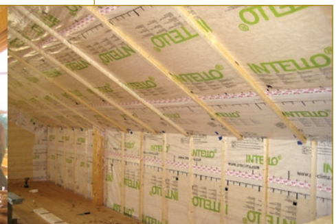
Рис. 12. Строительство объекта: возведение каркаса, утепление здания, устройство пароизоляции, монтаж окон, проведение BlowerDoor теста, монтаж ветрозащиты.
