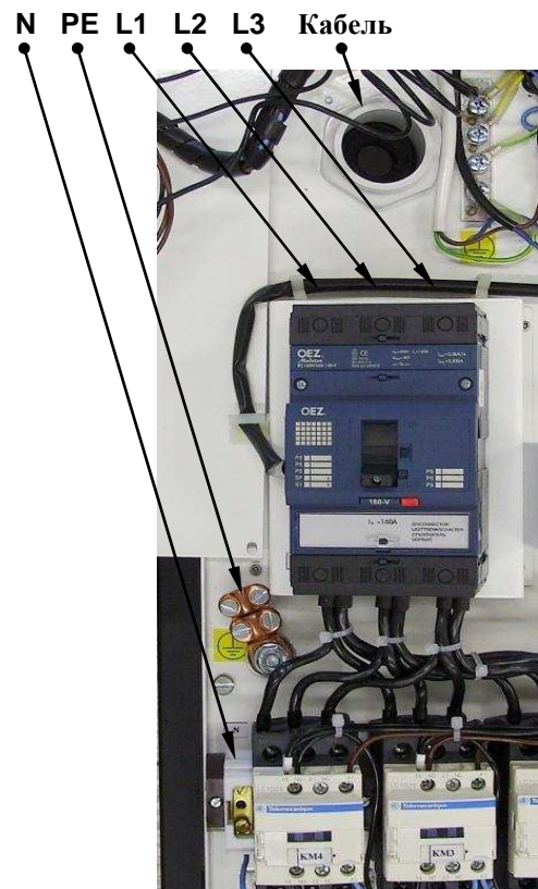
Рис. 21. Подключение входного кабеля котла «Daline PTE 22 – 60»
