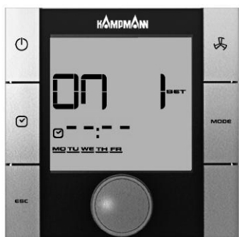
Режим ввода «Время включения»
