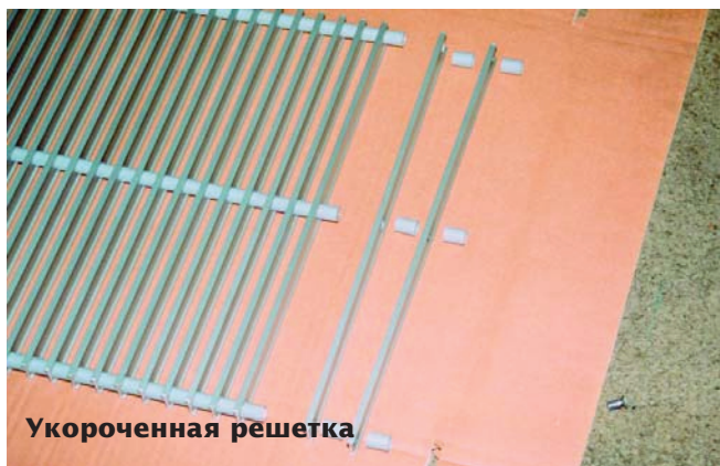
Шаг 6: Укорачивание оставшихся пружин
