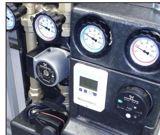
На насосно-смесительной группе в теплоизоляции, где корпус Контроллера размещен прямо на теплоизолирующей вставке. Здесь контроллер управляет сервоприводом ESBE с аналоговым входным сигналом 0-10в. Реле используется для включения-выключения обычного энергосберегающего насоса Grundfos Alpha-2 или Alpha-2-L.
