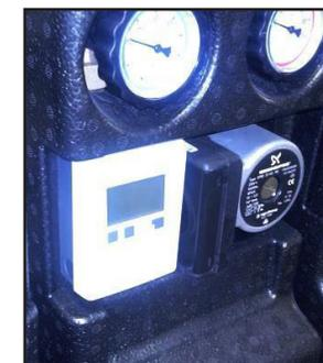
На этом фото Контроллер управляет специальным энергосберегающим насосом Grundfos UPM, который изменяет обороты в зависимости от выходного управляющего сигнала контроллера 0-10в.
