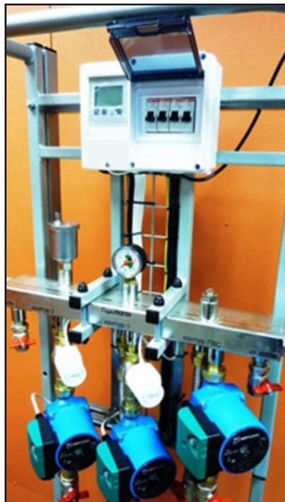
Управляемый Модуль Нано до 40кВт
