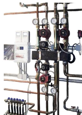
Не Модуль ГидроЛОГО. Заказчик выполнял монтаж установки самостоятельно в полевых условиях. Использовал для управления 2 контроллера SmartWeb L.
