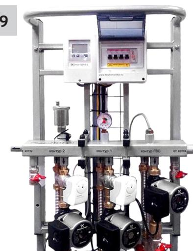
Перерождение популярного Модуля НАНО с новым управлением от SmartWeb L и сервоприводами 0-10в от Siemens.
