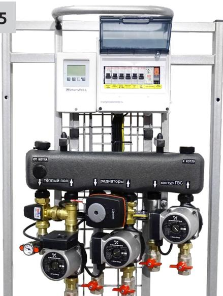
Два похожих миниатюрных Модуля с потребителями DN20, на основе общего коллектора в теплоизоляции, с регулируемым от 0 до 100% открытием гидрострелки. В управлении участвуют как SmartWeb L, так и SmartWeb S.
