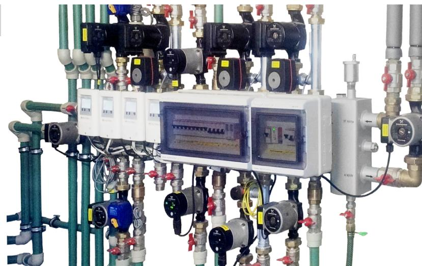
Смонтированный Модуль ГидроЛОГО на основе коллектора Супер-Стандарт с несколькими контроллерами SmartWeb, которые управляют энергосберегающими насосами Grundfos UPM-GEO 25-85 с переменными оборотами, сервоприводами ESBE SmartDrive 0-10v + PWM, зонными клапанами, «обычными» и ALPHA-насосами потребителей, котлами.
