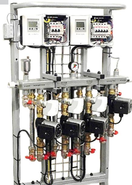
Тот же Модуль с дополнительным смесительным потребителем на расширенном кольцевом коллекторе с управлением от 2-х SmartWeb L, которое выполняет и внешнее управление модулированием выходной температуры (или мощности) котла сигналом 0-10в.
