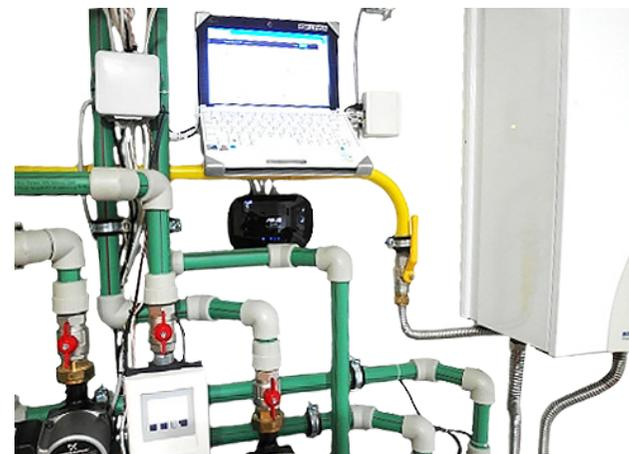
Здесь в кадр попали и контроллер SmartWeb L, и DataLOGGER, и EtherNET роутер и даже нетбук с анимированной картинкой локального мониторинга по CAN-bus цепочки из 12-ти контроллеров SmartWeb.
