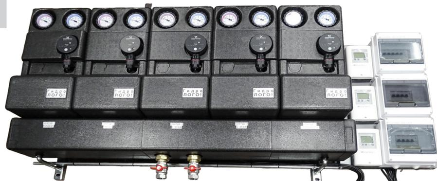
Другой управляемый Модуль на 5 потребителей DN25 под управлением 3-х SmartWeb L в бокс-сборках, которые размещены на отдельном щите со шлейфом проводов по требованию заказчика.
