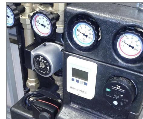
На насосно-смесительной группе в теплоизоляции, где корпус Контроллера размещен прямо на теплоизолирующей вставке. Здесь контроллер управляет сервоприводом ESBE с аналоговым входным сигналом 0-10в. Реле используется для включения-выключения обычного энергосберегающего насоса Grundfos Alpha-2 или Alpha-2-L.
