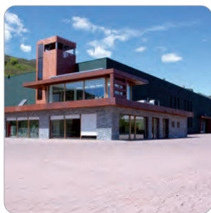
NEW PRODUCTION UNIT San Maurizio d'Opaglio (NO)
