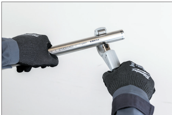
Рис. 7 Обрезка трубы d15-54 мм
