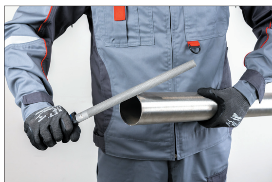
Рис. 10 Снятие фаски с трубы d76,1-108 мм
