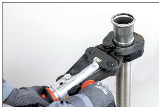
Рис. 18 Запрессовка (обжим) соединения
