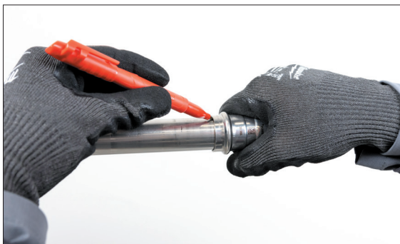
Рис. 12 Отметка глубины вставки на трубе
