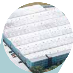
Завод по производству труб, г. Берлин, Германия
