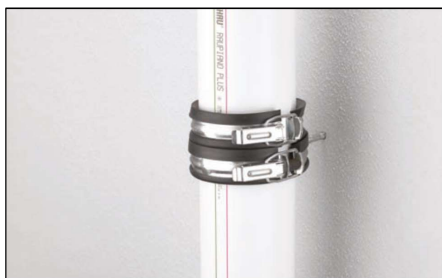
Рисунок 3 - Шумопоглощающий хомут в смонтированном состоянии
